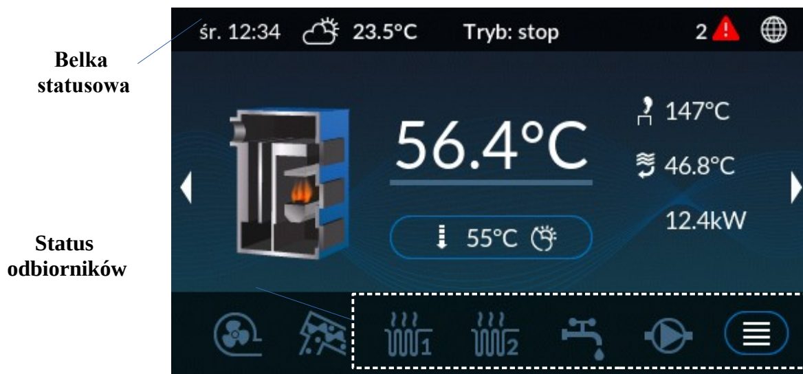
Ilustracja 9: Ekran główny, ekran kotła C.O.
